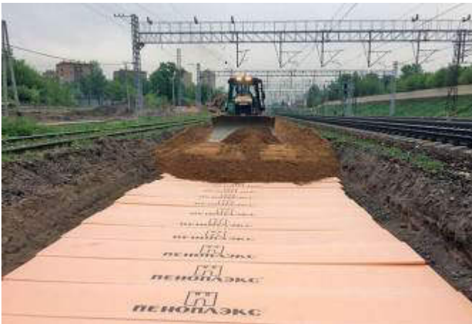
Рис. 4. Пример прокладки дополнительных железнодорожных путей участка дороги Москвы-Химки-Крюково
