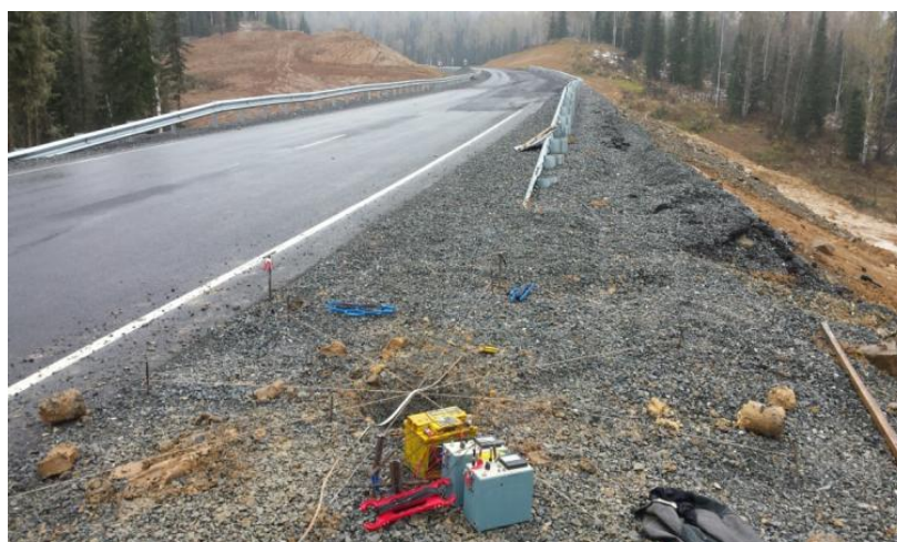
Рис. 2. Общий вид оборудования
